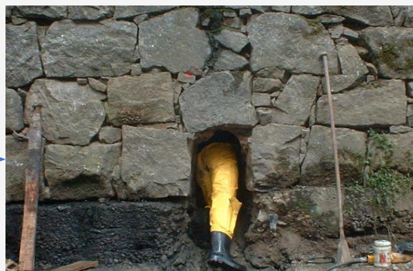
3 - Abertura de rasgo no muro
