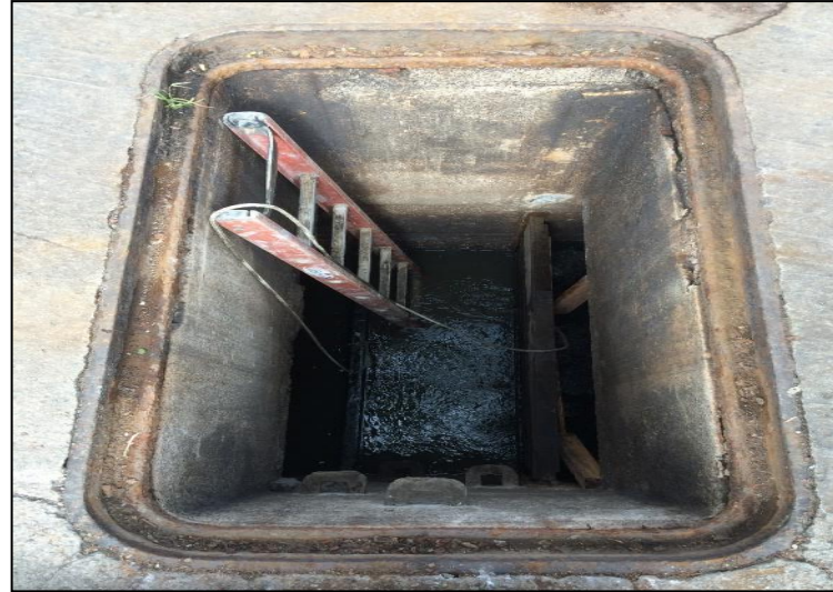
R. Dois de Dezembro, Flamengo - Rio de Janeiro
